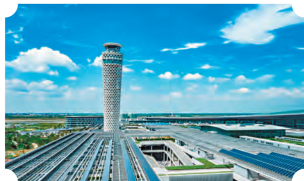
青岛胶东机场太阳能光伏发电项目
